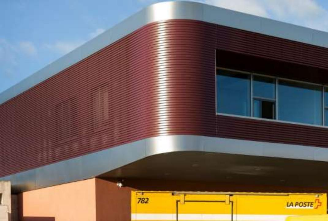
Beispiel Post: Fassade aus Metaldeckenprofilen
