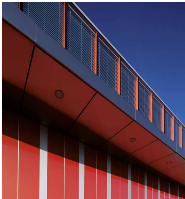
Stolze Höhe: Der Fachmarkt verfügt über geschosshohe Fenster. Hochreflektierende Lamellen werfen Sonnenlicht und Wärme zurück.
