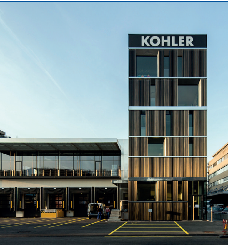
Kommissionierhalle und Büroturm sind mit CNS Blechen verkleidet,...
