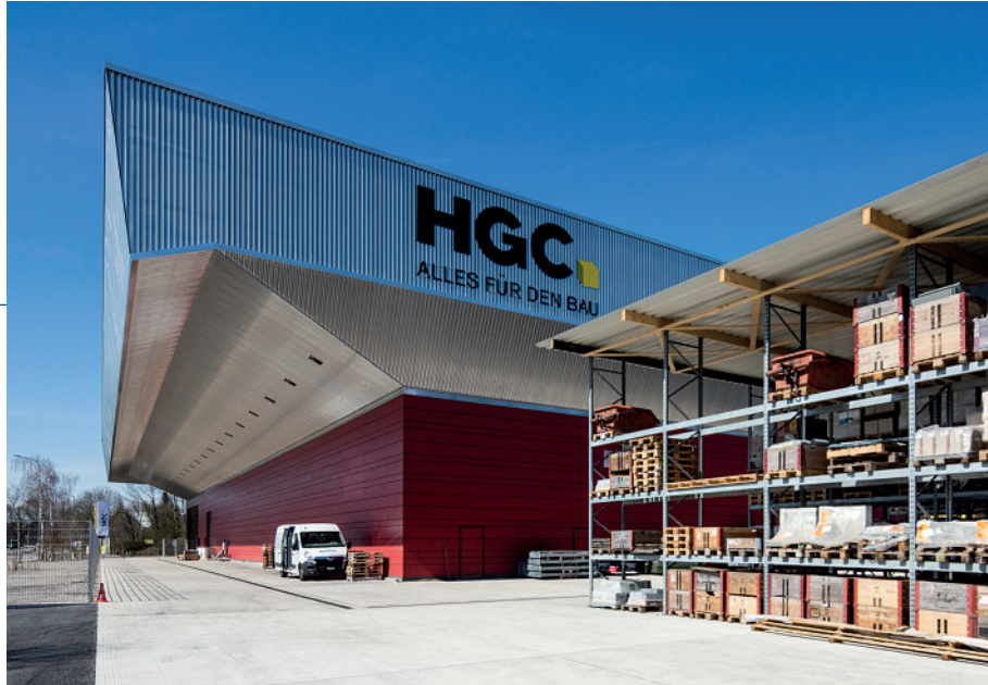
Das weit auskragende Dach der Lager- und Logistikhalle schützt die seitlichen Umschlagplätze.
