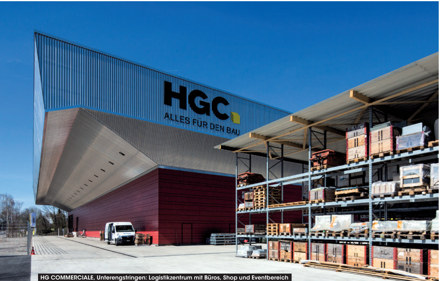
HG COMMERCIALE, Unterengstringen: Logistikzentrum mit Büros, Shop und Eventbereich
