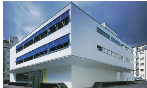
Beispiel Beleuchtung: Hauptsitz WWF Schweiz, 1992-94
