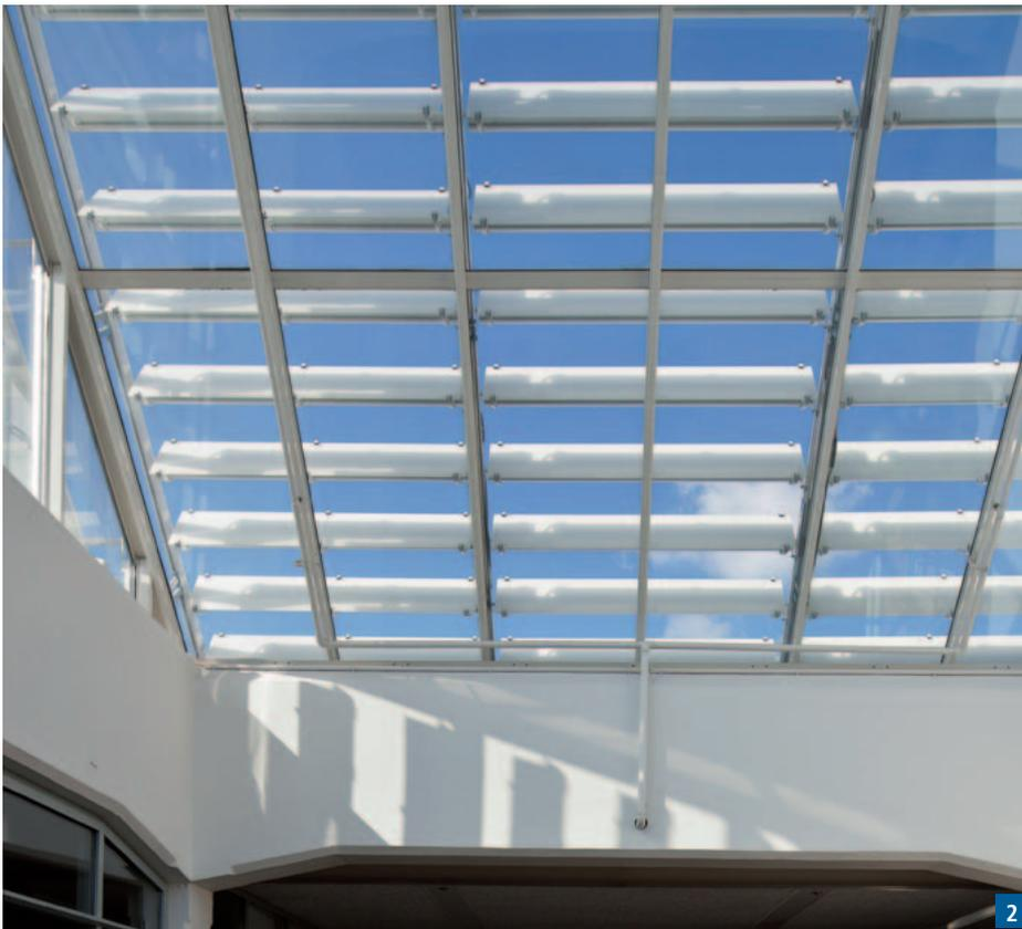
**1** Die vollautomatische Beschattungsanlage am aufgesetzten Glas-Satteldach sorgt bei jedem Wetter für die optimale Kombination aus Sonnenschutz und Lichtlenkung
