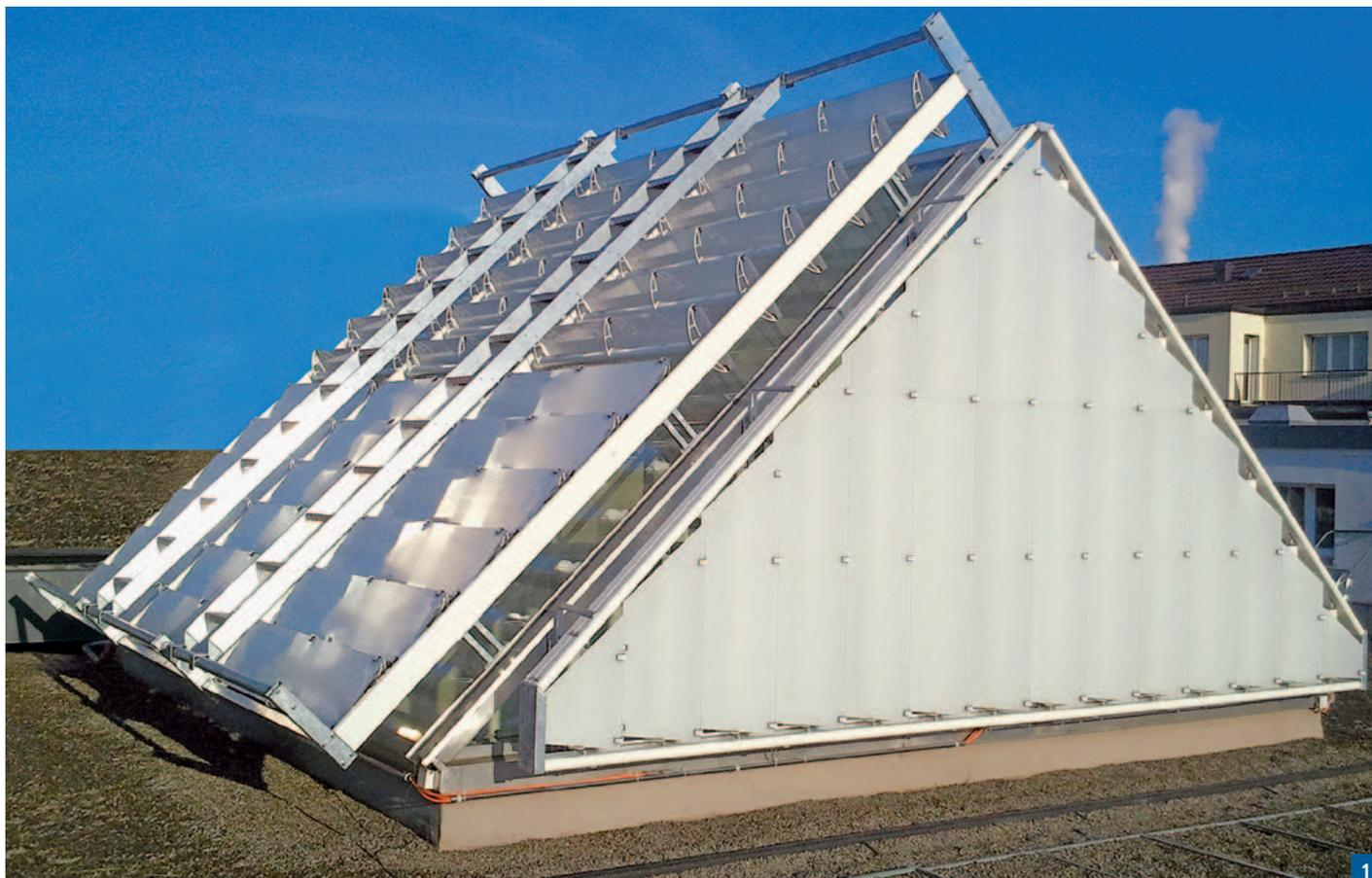
**In der Schweizer WWF-Zentrale sorgt eine vollautomatische Lamellen-Lichtlenkungsanlage für eine effiziente Lichtverteilung und einen angenehmen thermischen Komfort. Entwickelt und realisiert wurde das Konzept von Reynaers AG.**
